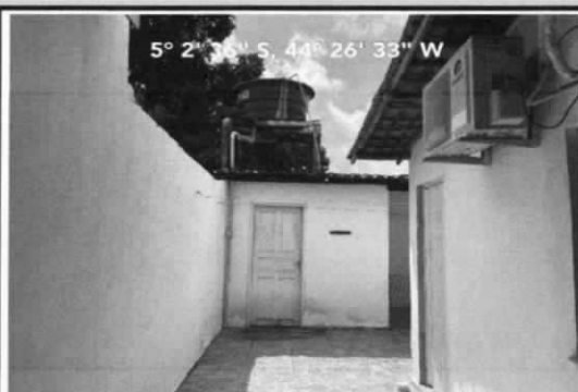
FOTO 11 - ÁREA EXTERNA CAIXA D'ÁGUA ELEVADA Fortlev 500 L
